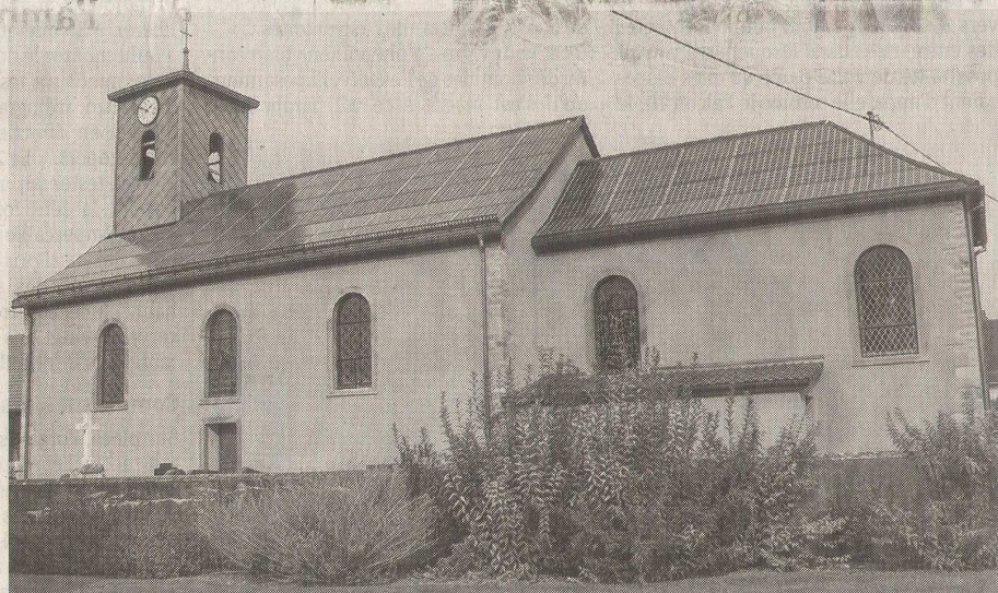
À Boesenbiesen, qui accueillera mardi la soirée intercommunale consacrée aux énergies renouvelables, le toit de l'église est recouvert de panneaux solaires. PHOTO DNA
